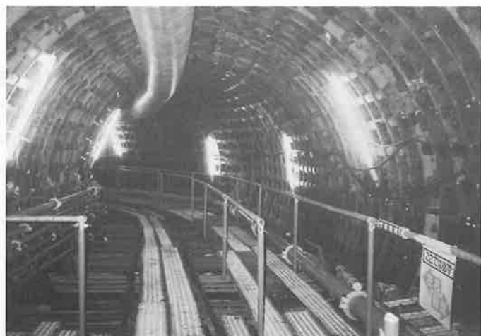
本立坑からみた工事中の馬込幹線
