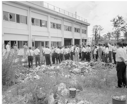
▲津波被害により使用不能となった中学校
