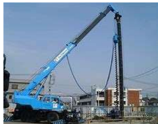
山留H鋼打込
