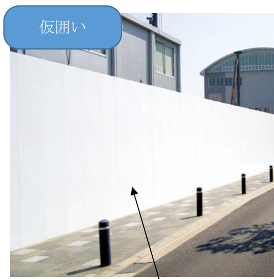
校庭グラウンド部工区仕切り仮囲い
