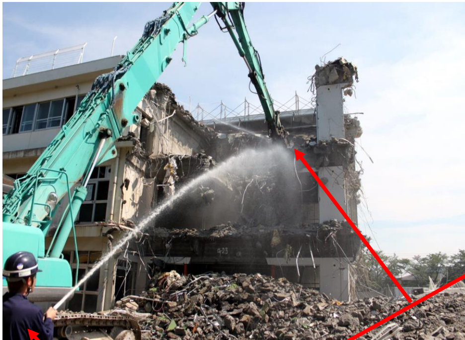
【 油圧式圧砕工法と散水状況 参考例 】
