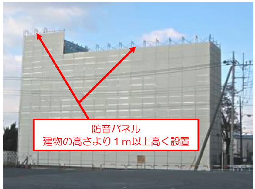
【 枠組足場・防音パネル 参考例 】
