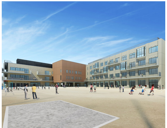
グラウンド側から見る
