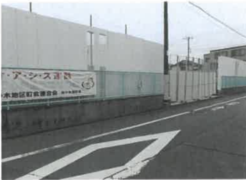
仮囲い既設パネル利用
