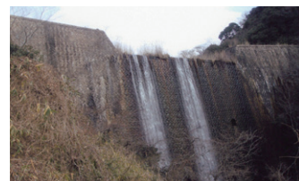
ごすけえんてい 五助堰堤（兵庫県）
