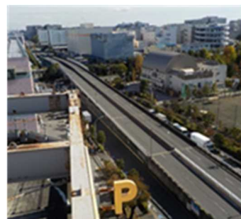
平和島陸橋（北側）（南側）
