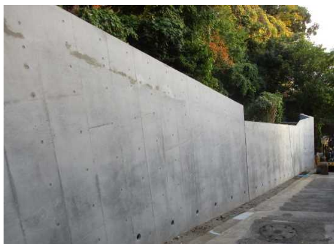
【助成金を活用した擁壁整備工事例】
