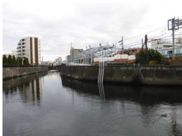
施設整備工事現場全景
