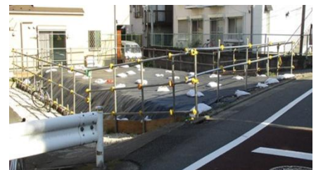
除却後の現場
