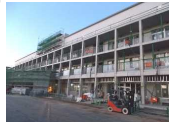
志茂田小学校 新校舎写真
