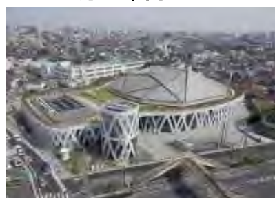
大田区総合体育館
