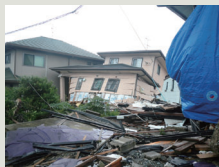
ゆれによる被害の様子 (熊本県益城町)
