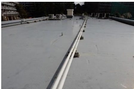
塗膜防水の防水層は良好
