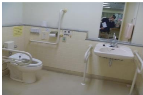
だれでもトイレは設置後間もないため良好
