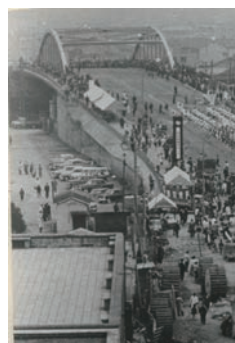
蒲田陸橋開通 (昭和37年)
