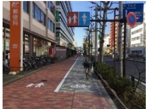
インターロッキング舗装上の整備事例 (蒲田地区の環八通り)
