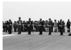
羽田新A滑走路完成 (昭和63年)
