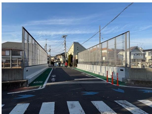
写真 4.9 稲荷橋（JR 跨線橋）：白色で再塗装された壁高欄
