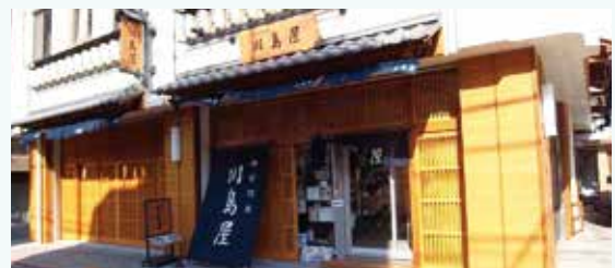
○店先に、開口を設け店内の様子や活動が見えるようにしています。隠す部分は格子戸などを用いて表情を豊かにしています。(大森本町 C5)
