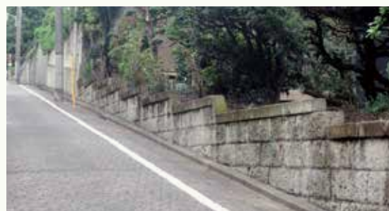
○大谷石の階段状の擁壁が、坂道の表情をつくっています。(南千束 D6)
