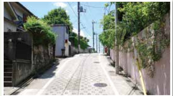
起伏のある地形、曲線のある 道路沿道の景観
