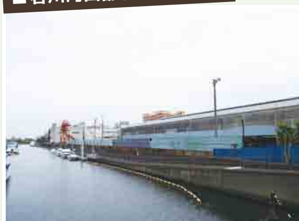
呑川沿いの物流施設等が建ち並ぶ街並み
