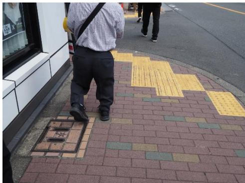
視覚障がい者誘導用ブロックの点検 (多摩堤通り)
