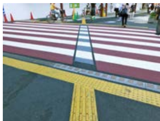
横断歩道にエスコートゾーンを設置(蒲田駅東口駅前)
