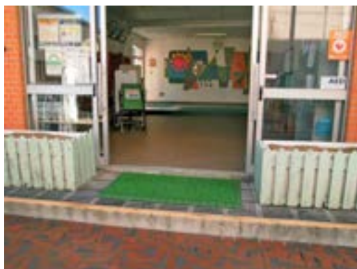
段差のある出入口
