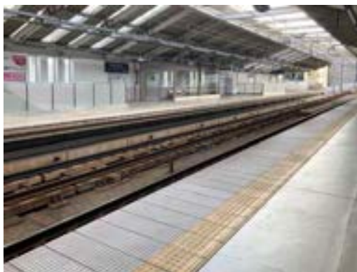
ホームドアが設置されていないプラットフォーム
