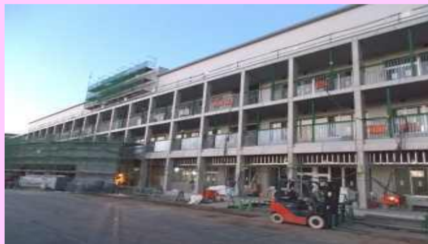
志茂田小学校 新校舎写真
