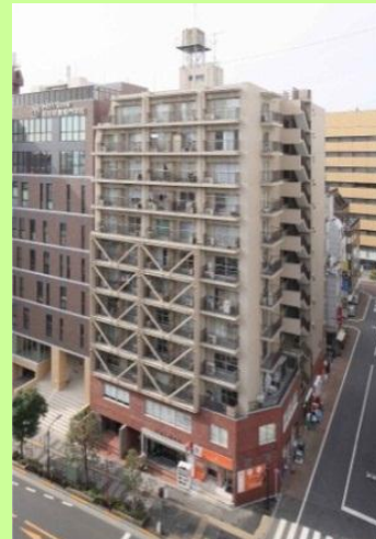
区の助成を受け、耐震改修工事を行った分譲マンション
