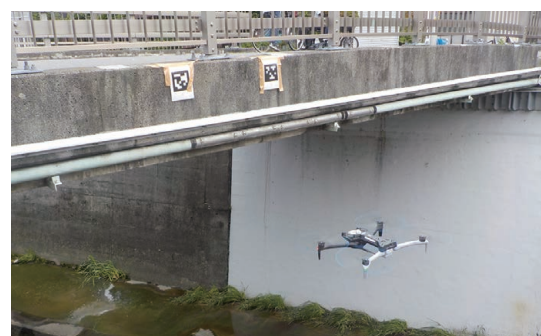
ドローンによる橋梁点検
