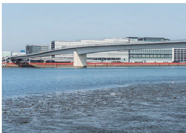
多摩川スカイブリッジ
