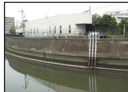
浄化施設建屋全景
