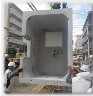
電線共同溝整備工事
