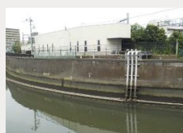
浄化施設建屋全景
