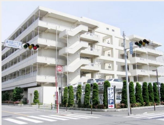
本羽田二丁目第2工場アパート
