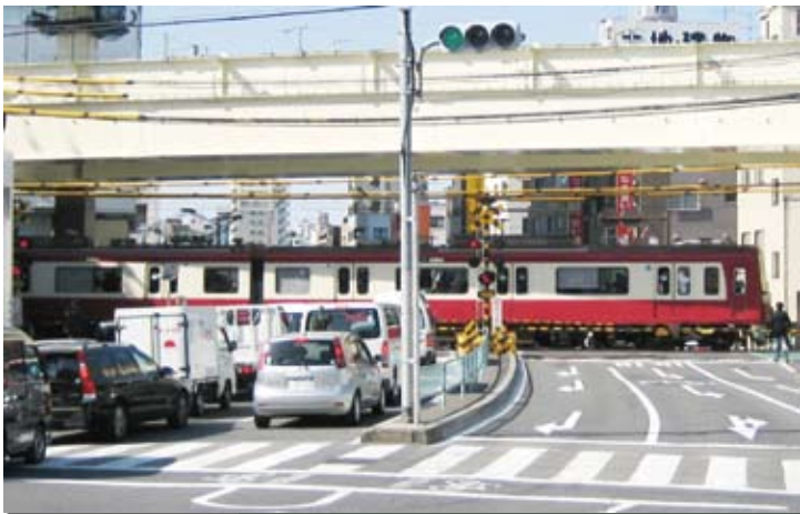
梅屋敷第4踏切(多摩堤通り)：平成21年2月現在
