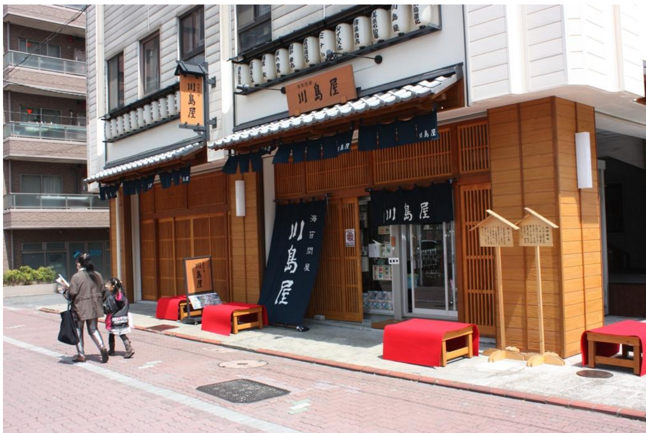
景観整備工事竣工後のミハラ通り商店街
