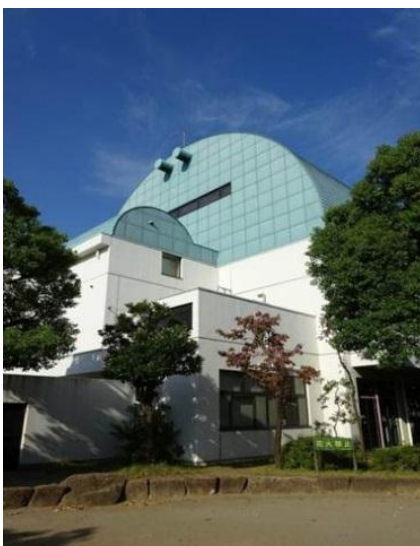
再整備予定の平和島ユースセンター
