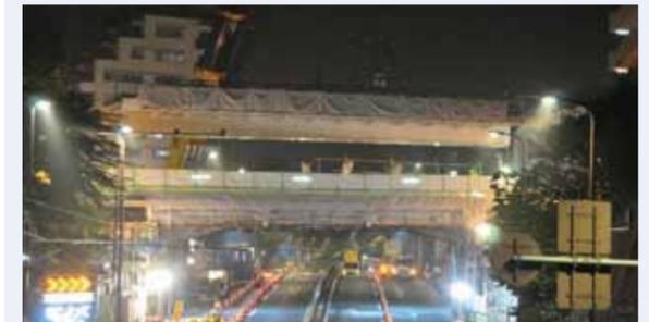
新馬込橋架替工事(上部工架設)。橋の下の道路は環状七号線。橋が崩落すると環状七号線は通行できなくなり、災害時の輸送活動などが滞るため、架替えによる耐震性強化が重要。
