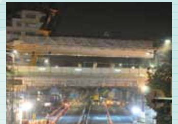
新馬込橋架替工事
