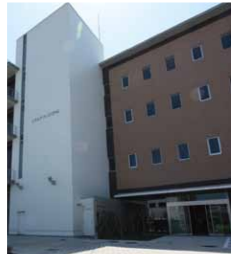
平成24年6月に開設した東糀谷六丁目工場アパート (OTAテクノCORE)
