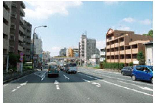
建物不燃化促進(第二京浜国道)
