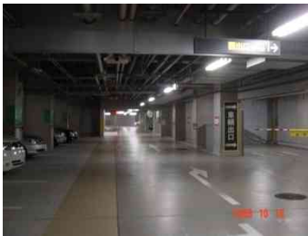
【大田区営アロマ地下駐車場】
