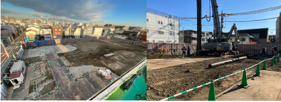
基礎解体工事
