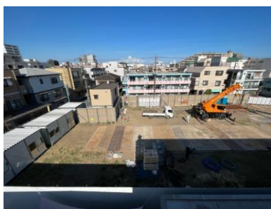
仮設・山留工事
