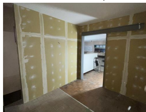
既存棟改修工事
