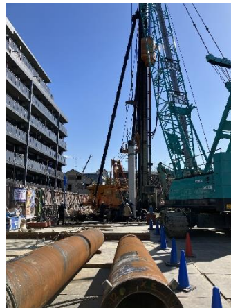
地業・土工事
