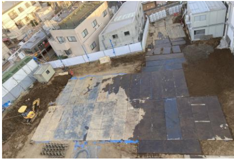
新築工事着手
