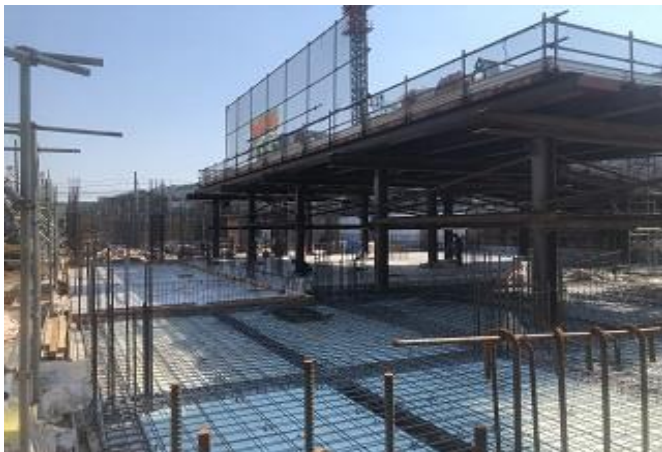
地下躯体工事
