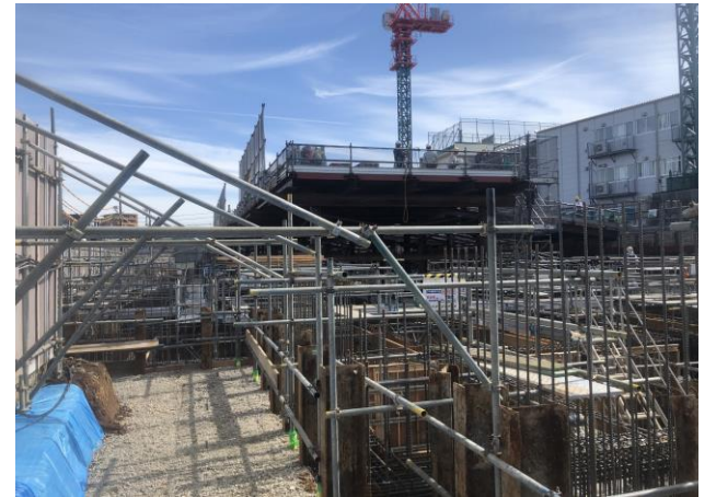
基礎躯体工事
