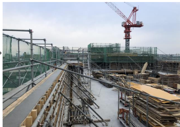
地上躯体工事
