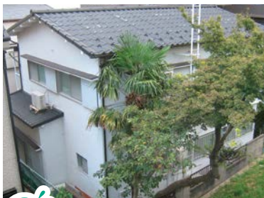
解体工事前(令和2年8月14日)
