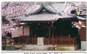
屋根瓦葺き替え
