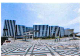
羽田イノベーションシティ外観
