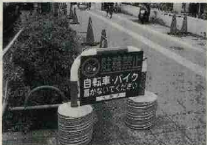
歩道に設置したバリケード
