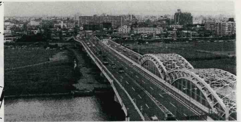
⑩六郷橋 上り車線が開通した昭和 59 年 8 月 1 日、大田区広報課撮影。橋に近い川岸には木橋時代の橋台の石垣が残っている。美しい 2 連のアーチをもつ旧六郷橋の跡に、下り車線が完成したのは平成 9 年 11 月 15 日である。
