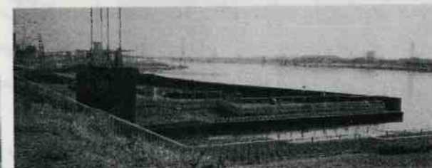
②六郷ポンプ場(昭和48年6月竣工)の排水口
