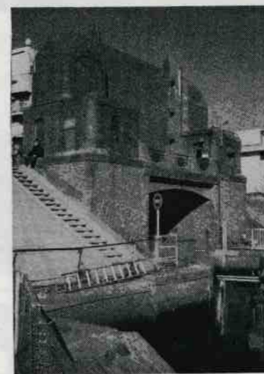
①六郷水門 大正中期からの耕地整理により都市排水路に転換した六郷用水の吐け口として、昭和6年3月に竣工。総工費70,000円のうち国庫補助30,000円、残りは地元が負担した。運河の橋の欄干にあるのは、当時の六郷町の町章である。
