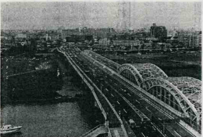
現在の六郷橋。開通したのは昭和59年(1984)8月1日。大田区広報課が川崎側の上空から撮ったもの。架け替えられた六郷橋の2連のアーチがまだ、姿をとどめている。
